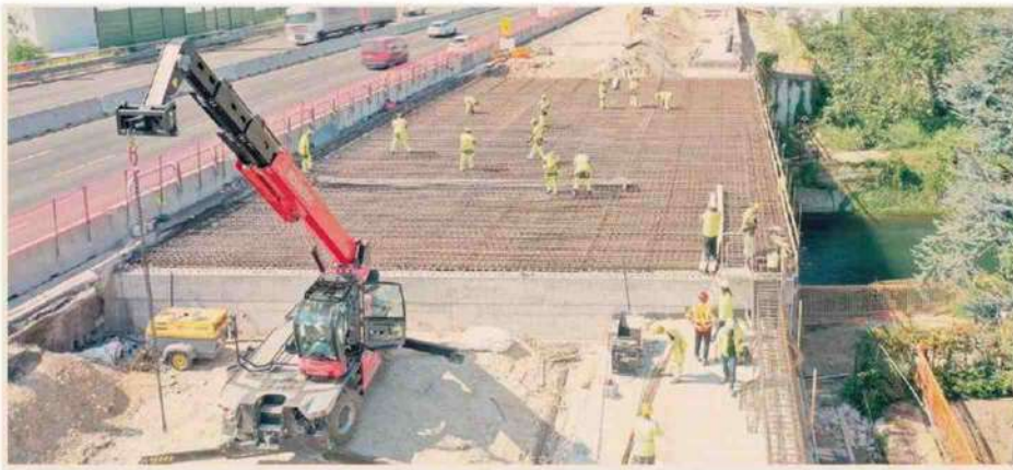
Grandi opere. Un cantiere per l'ampliamento di un tratto autostradale
