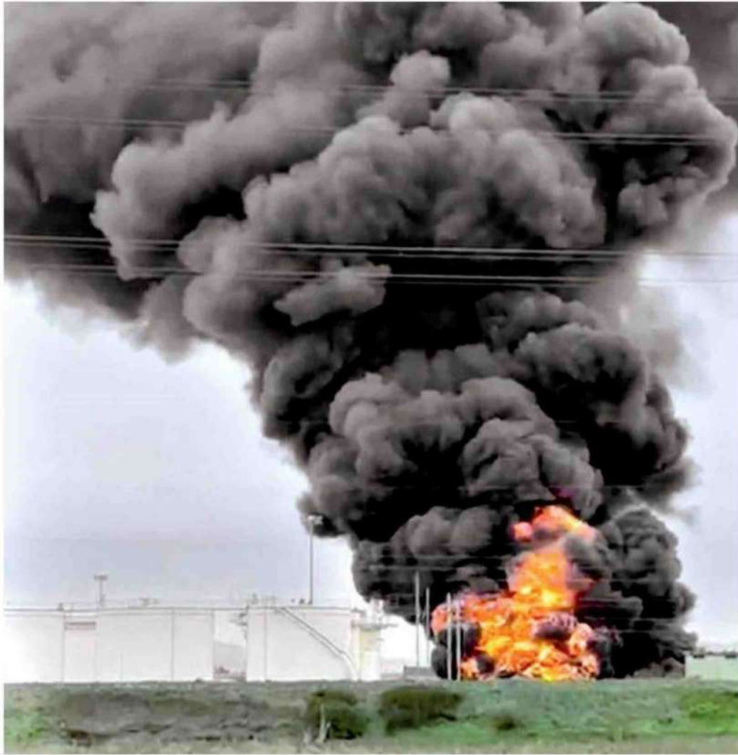
▲ Esplosione Le fiamme divampano davanti alla raffineria dell'Eni nel comune di Calenzano
