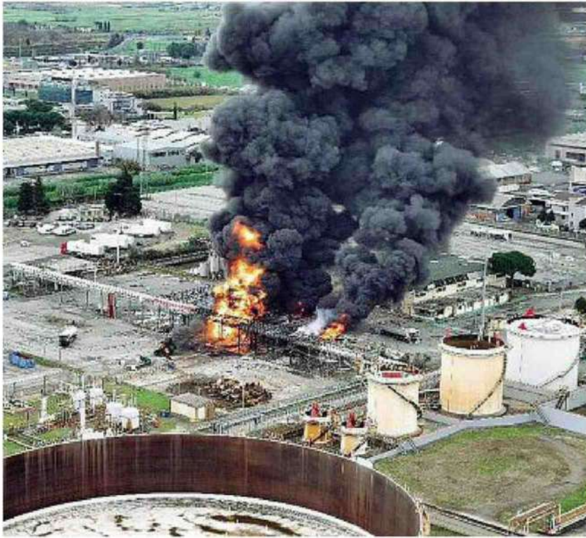
L'immagine del deposito di Calenzano dove si è verificata l'esplosione che ha provocato due vittime
