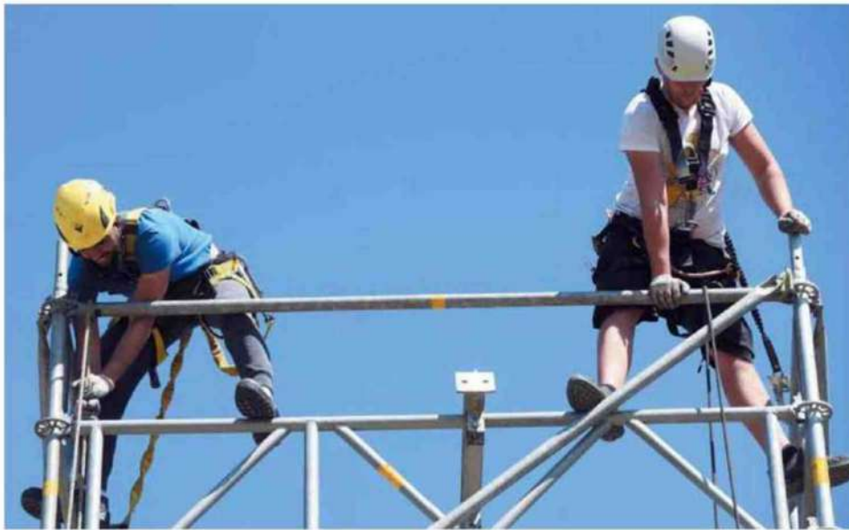
Operai al lavoro su un ponteggio
